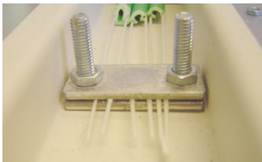
Första lagret dragavlastat.
