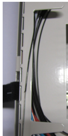
Tubkabel 48-fiber samt anslutningar för 5 mm rör med mikrokabel (kund)
